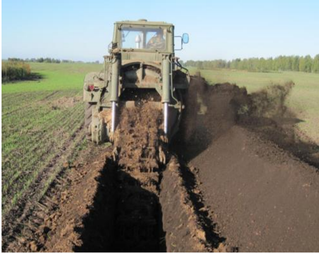
PZM-2 földmunkagép árokásás közben 37
