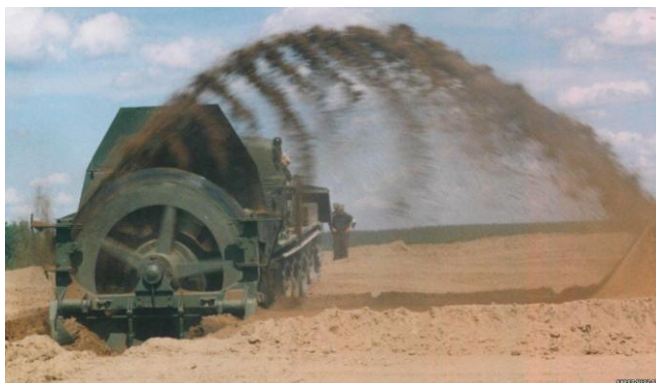
Az első munkafogás 28
