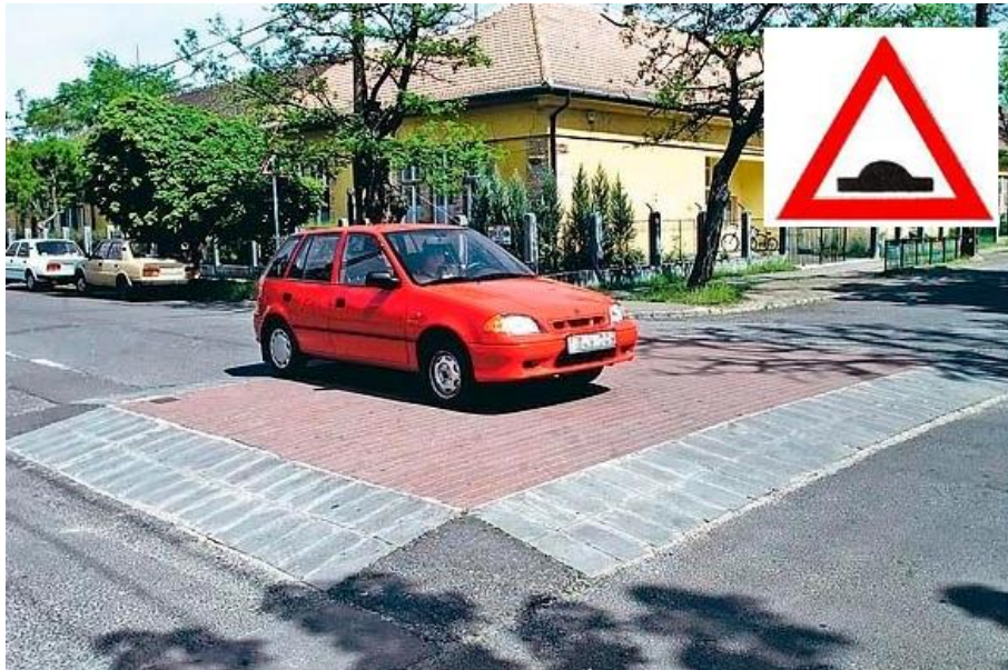
10. kép Bukkanó és figyelemfelhívó tábla 11
