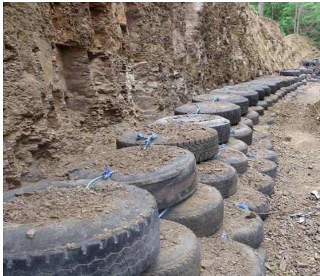
4. kép Kerékabroncsból készített akadály 5
