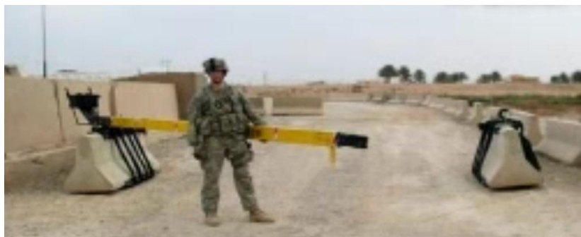
28. kép T fal és megerősített sorompó kombinálása 28
